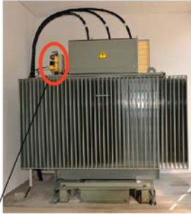
Transformateur HTA immergé dans l'huile
