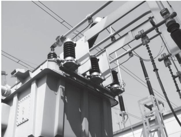
Figure 1.2 – Raccordement d'un tertiaire de transformateur
