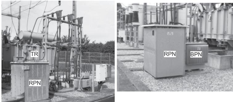
Figure 1.6 – Mises à la terre du neutre HTA dans l'environnement d'un transformateur 92 kV/21 kV
