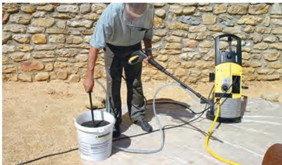
1 Utilisez un nettoyeur haute pression avec lance de sablage. Enfoncez la canne d'aspiration dans le sable.
