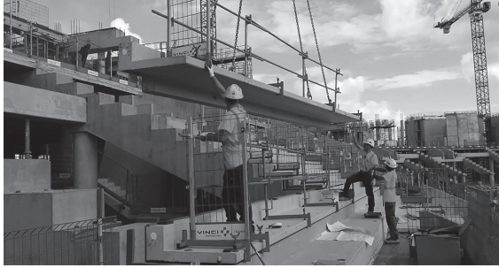
Figure 1.5 Pose de gradins préfabriqués dans un stade
