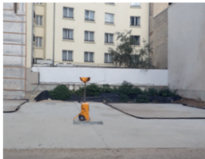
Terrain vague en voie de bétonnage.
