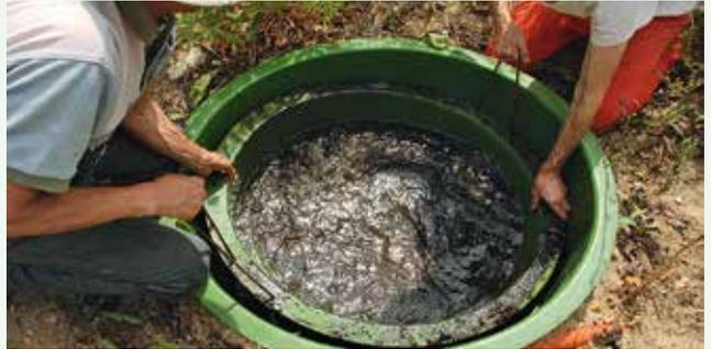
Il faut bien être deux pour retirer le 2<sup>e</sup> filtre, fragile et prompt à se renverser.
