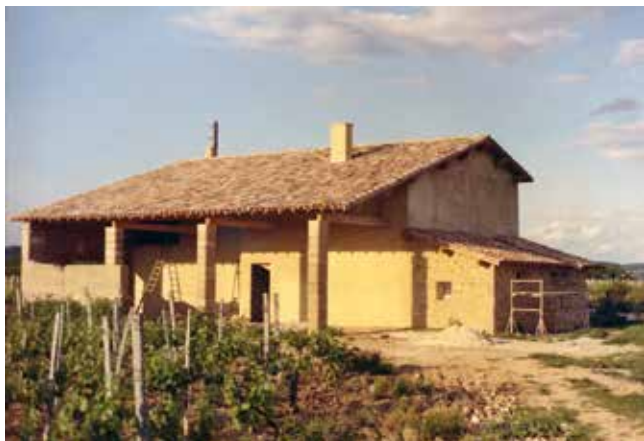
La maison en 1973 à la fin des travaux.
